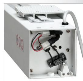
Elektroinstalace včetně dodatečného mikropřepínače
