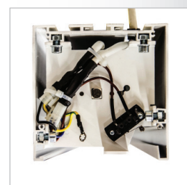
Elektroinstalace včetně dodatečného mikropínače
